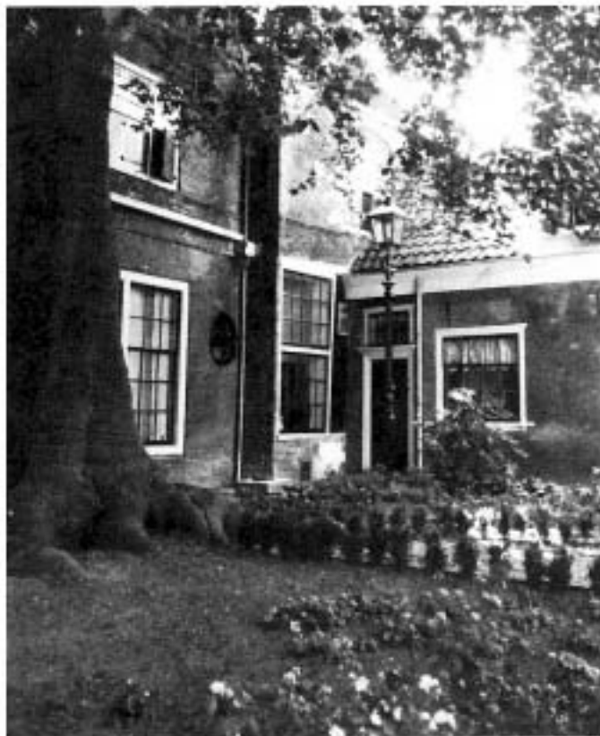
Het Claes Stapelhofje: de fraaie restauratie is de bekroning van het werk van Stadsherstel.
