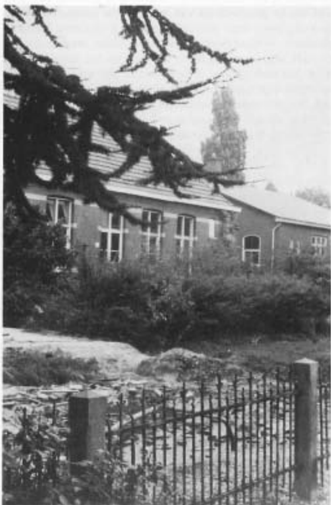
Het resultaat na de afbraak, gezien vanuit de Pieter Florisstraat
