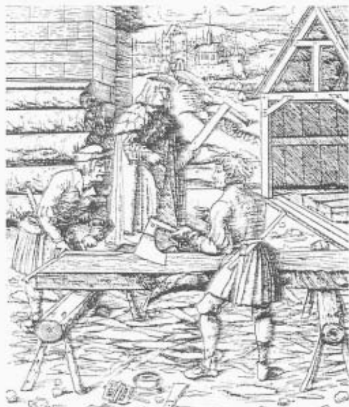
Tekening van omstreeks 1515, waarop het kantrecht van een balk met de timmermansbijl is weergegeven.
